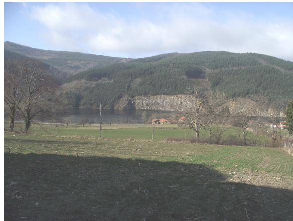
barrage du Dorlay
