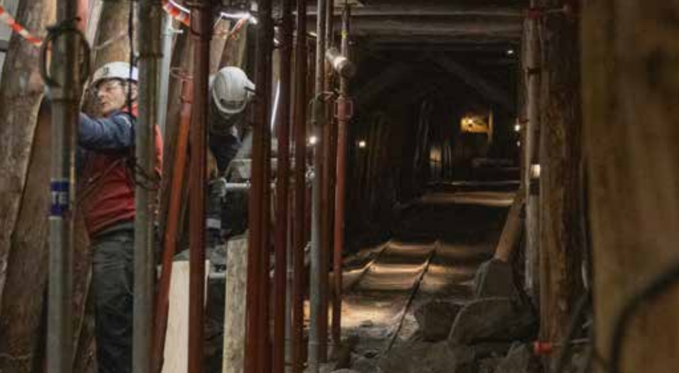
La galerie de mine reconstituée en cours de consolidation.
