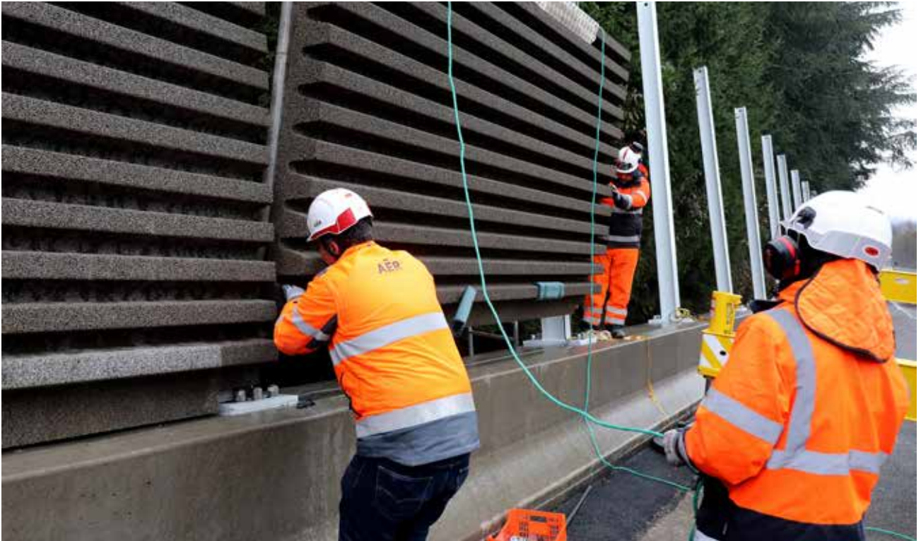
240 mètres de murs anti-bruit seront installés le long de la RN88.
