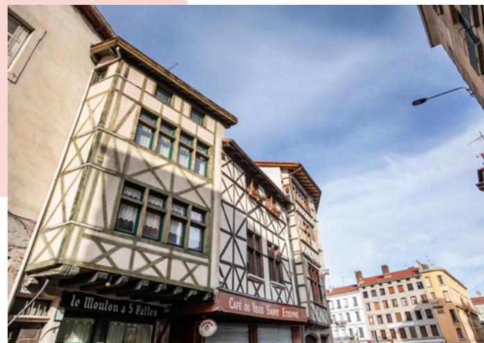
Maisons à colombage du bourg médiéval
