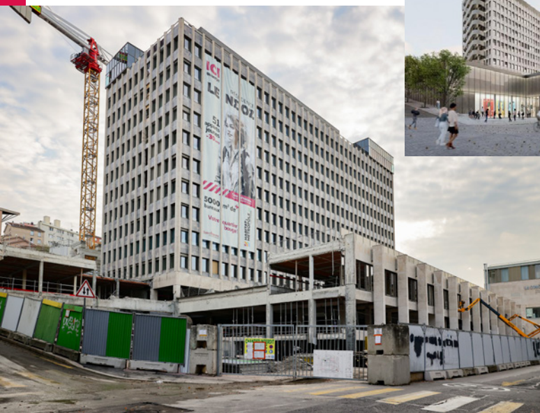
Restructuration en cours de l'immeuble et de l'avenue Loubet
