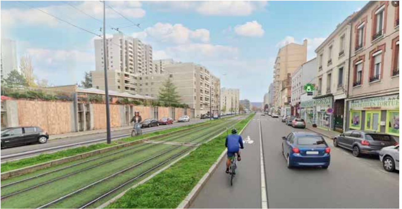
Une piste cyclable est en cours d'aménagement rue Bergson, de la Chaléassière à Grouchy.
