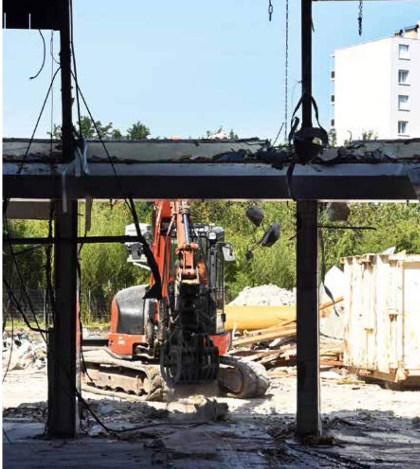
Le Flore, en cours de démolition boulevard Jules-Janin
