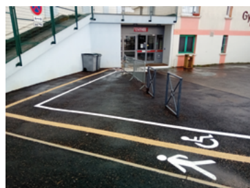
Gymnase Paul Michelin : marquage de l'accès et du cheminement PMR avec contraste.
