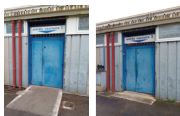
Gymnase Marc Seguin : travaux d'accessibilité des seuils de deux entrées vestiaires.
